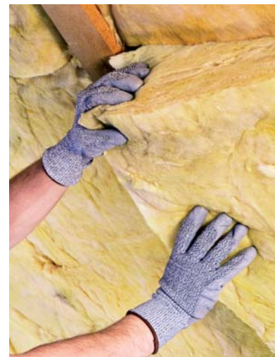
Haus mit Mütze: Ist das Schulhaus gut gedämmt, geht wenig Wärme verloren.
