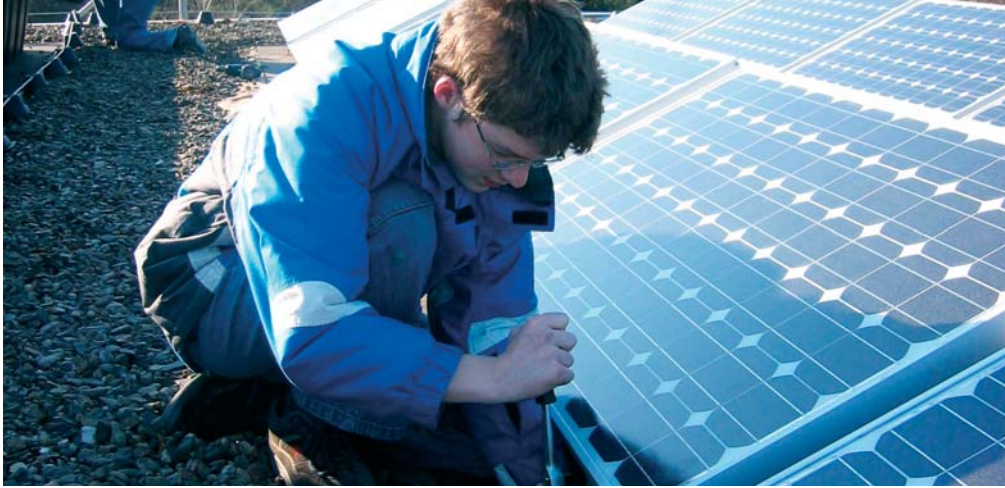
Selbst Hand anlegen: Am Otto-Hahn-Gymnasium Gifhorn wurde ein Großteil der Arbeiten in Eigenleistung erbracht.
