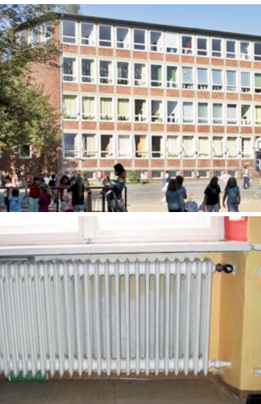
Schwachstellen vorprogrammiert: Viele Schulgebäude sind in die Jahre gekommen.
